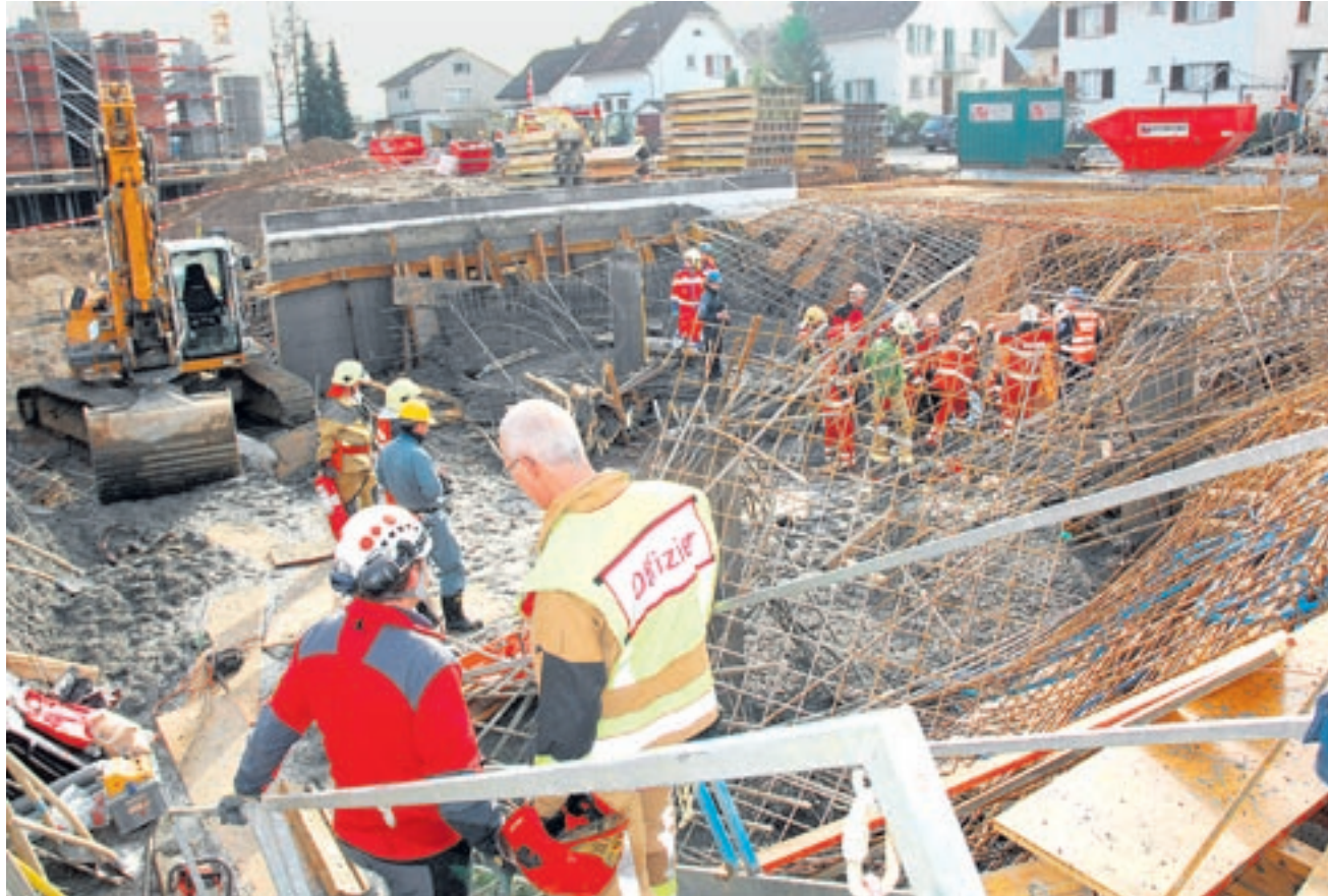
Die Rettungskräfte versuchten vergeblich, die Verschütteten unter der schweren Last noch lebend zu bergen. Bild: Markus Heinzer
